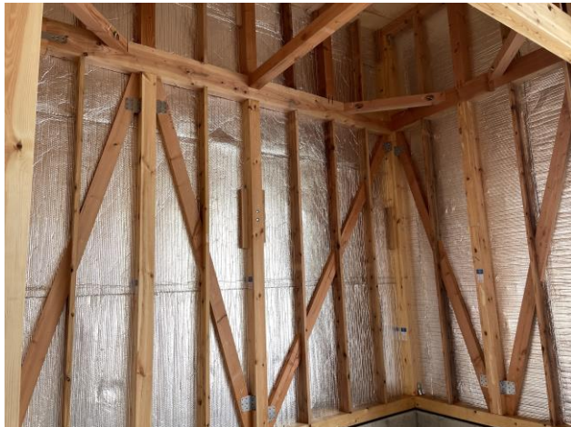
遮熱シートによって店内温度を安定させることで、年間約 4 トンの CO2 排出量を削減。
